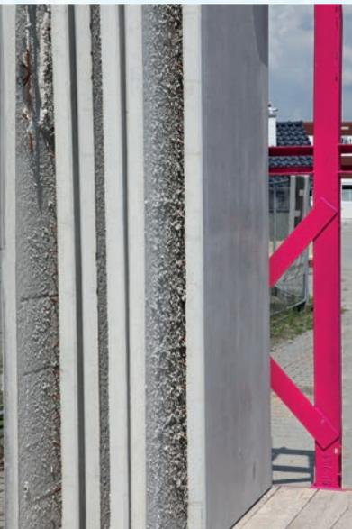
Das Doppelwandelement ist ein Halbfertigteil und besteht aus zwei Stahlbetonschalen, die durch Gitterträger miteinander verbunden sind.
